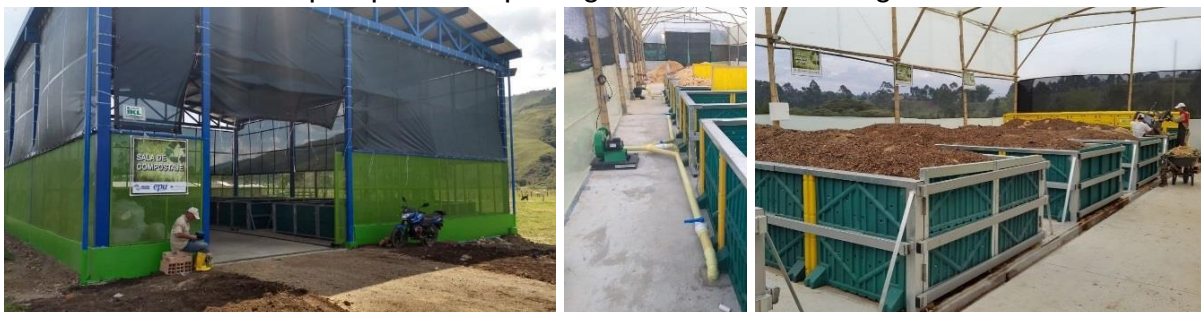
Foto 7 – Galpão para compostagem controlada, em grande escala.
