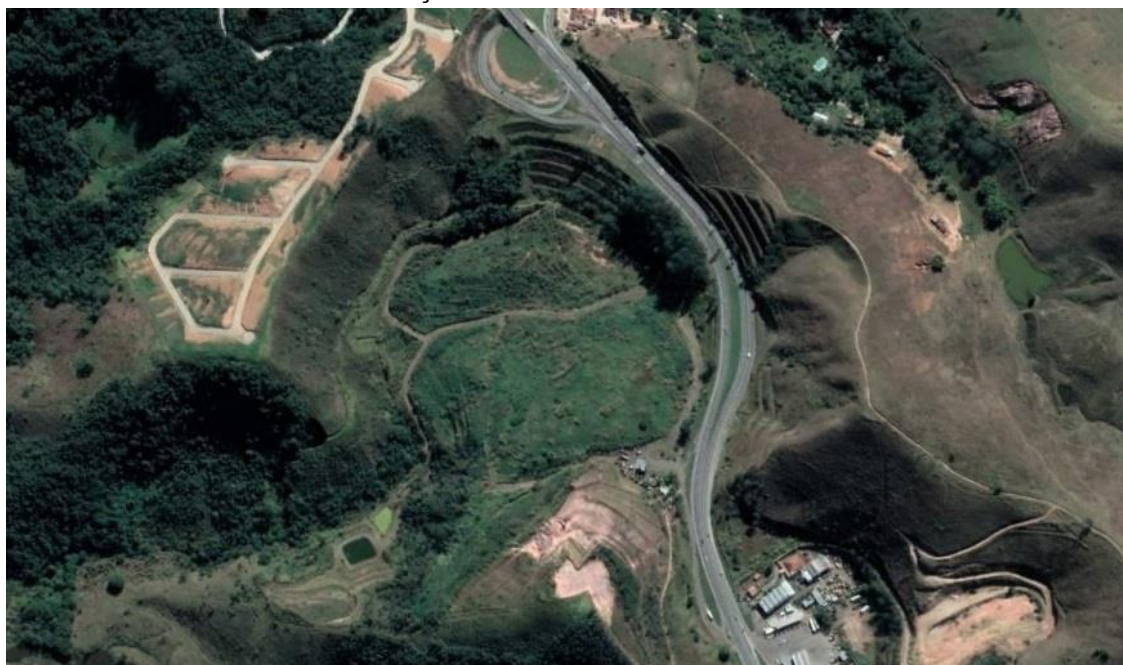
Foto 25 – Situação atual do Aterro Salvaterra, 2018.
