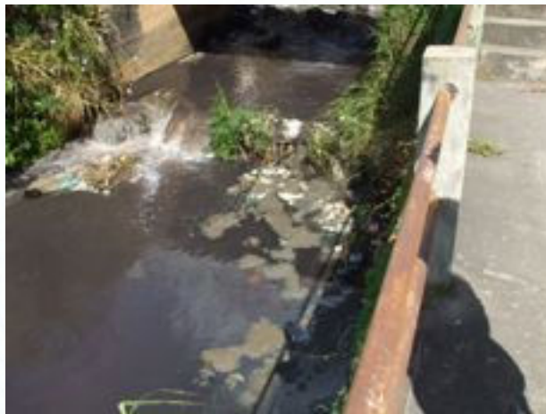
Foto 45 - Córrego Humaitá, BD 39 (Fonte: PJF, SO/Defesa Civil, 2009)
