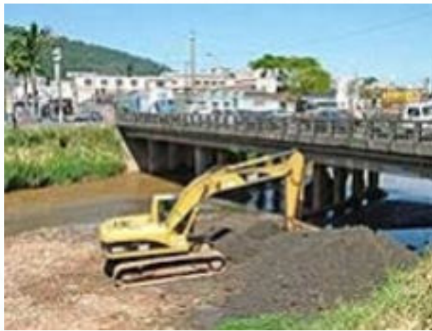
Foto 28 - Dragagem do Rio Paraibuna (Fonte: PJF-SO-Defesa Civil, 2009)
