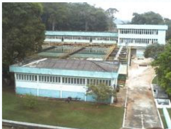
Foto 75 – Vista parcial da ETA Mal Castelo Branco (Fotos 74 e 75 – Fonte: Equipe UFJF/Fadepe - 2011)
