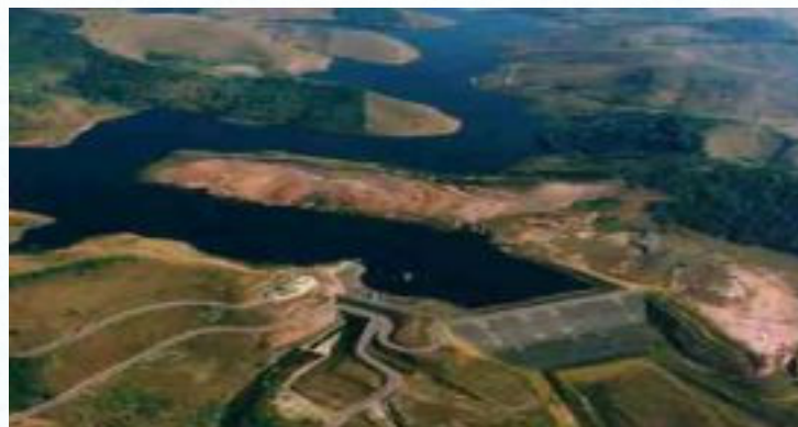
Foto 82 – Vista aérea da barragem de Chapéu D’Uvas (Fonte: Cesama - 2010)
