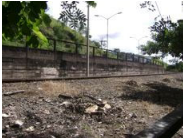
Foto 35 - Rua Doardino Longo (entulho e lixo)- Bairro Barbosa Lage - BD 32
