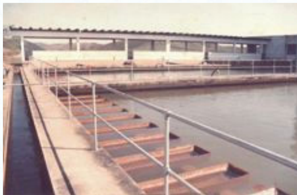
Fotos 64 e 65 – Sistema Sistema Norte: captação no ribeirão do Espírito Santo e ETA CDI (Fonte: Cesama - 2011)
