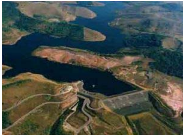
Foto 12 – Vista aérea da Barragem de Chapéu D’Uvas (Fonte: Cesama)
