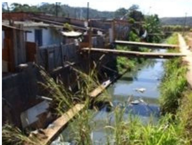
Foto 18 – Ocupação irregular às margens do córrego Santa Cruz – BD29 (Fonte: Defesa Civil – PJF, 2008)
