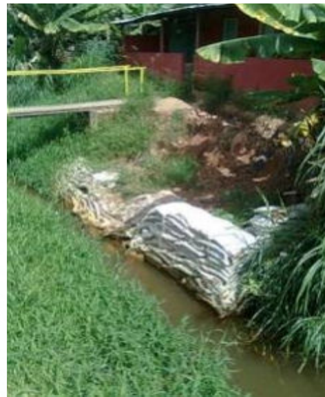
Foto 20 - Ponte de pedestres/ contenção de margem com rip-rap – Córrego Igrejinha - BD26
