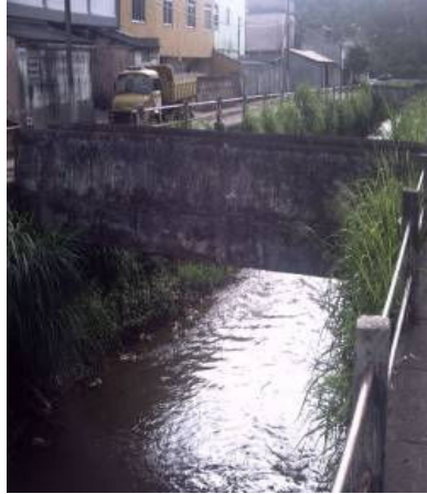
Foto 26 - Trecho canalizado, Córrego Humaitá, BD39 (Fonte: ESA/UFJF, 2011)
