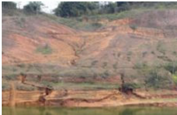
Foto 83 - Erosão por ravinamento
