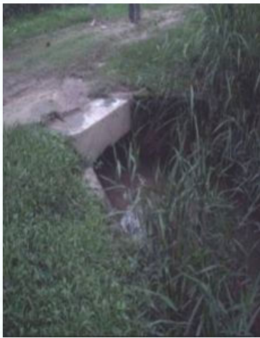
Foto 48 - Galeria pluvial à montante do córrego Humaitá, BD 39
