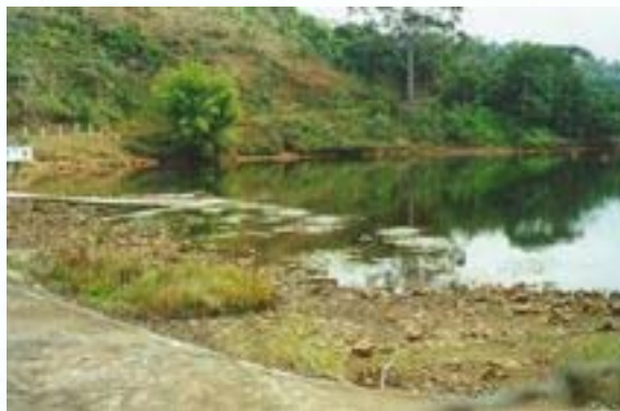
Foto 15 – Vista parcial do lago junto à estrutura de captação e extravasamento (Fotos 13 a 15 - Fonte: Cesama)
