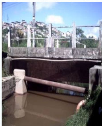
Foto 25 - Trecho canalizado, Córrego Humaitá, BD39 (Fonte: ESA/UFJF, 2011)
