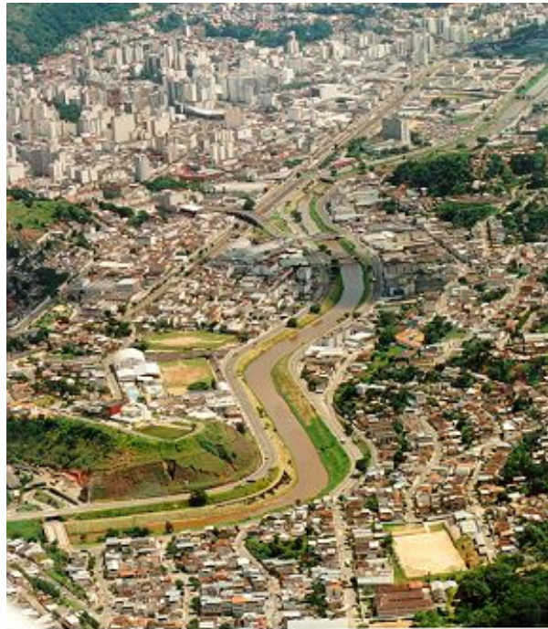
Foto 11 – Rio Paraibuna, com traçado já retificado, na área urbana de Juiz de Fora (Fonte: Arquivos - PJJ)
