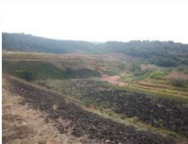
Fotos 67 a 69 – Obras de ampliação da ETA CDI e obras da adutora de água bruta (Fonte: Arquivo Equipe UFJF/Fadepe e Cesama - 2011)
