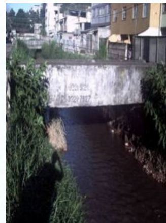
Foto 17 – Trecho canalizado, Córrego Humaitá Bairro Benfica, BD39 (Fonte: ESA/UFJF, 2011)
