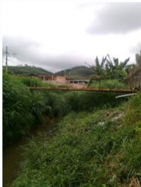
Foto 21 - Ponte de acesso à edificação, presença de resíduos sólidos e lançamento de águas residuárias diretamente no Córrego Santa Cruz – BD29 (Fotos 19 a 21 - Fonte: ESA/UFJF, 2011)
