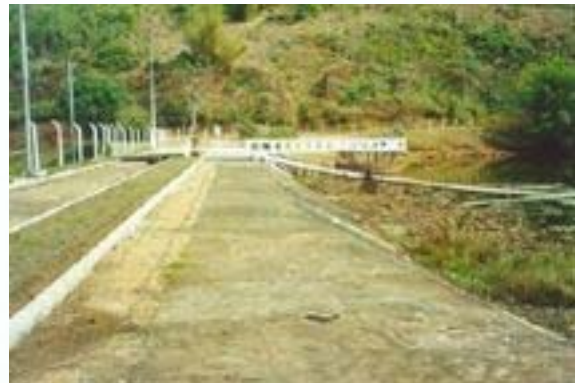
Foto 14 – Barragem e estrutura de captação e extravasamento
