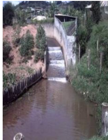
Foto 51 - Trecho concretado do Ribeirão da Rosas, BE 41
