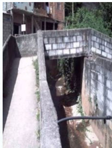
Foto 55 - Passarela sobre a galeria de águas pluviais, córrego Carlos Chagas, BD 41
