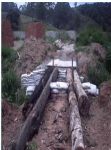
Foto 54 - Ponte irregular em construção sobre o Ribeirão das Rosas, BE 41
