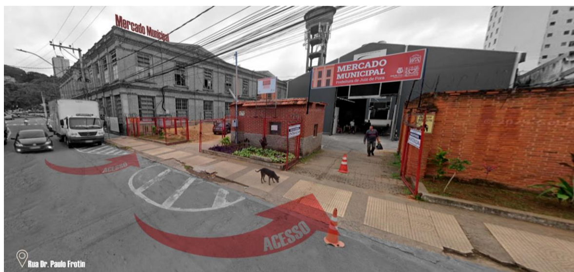
Figura 02: Fachada frontal e com acesso de veículos.
