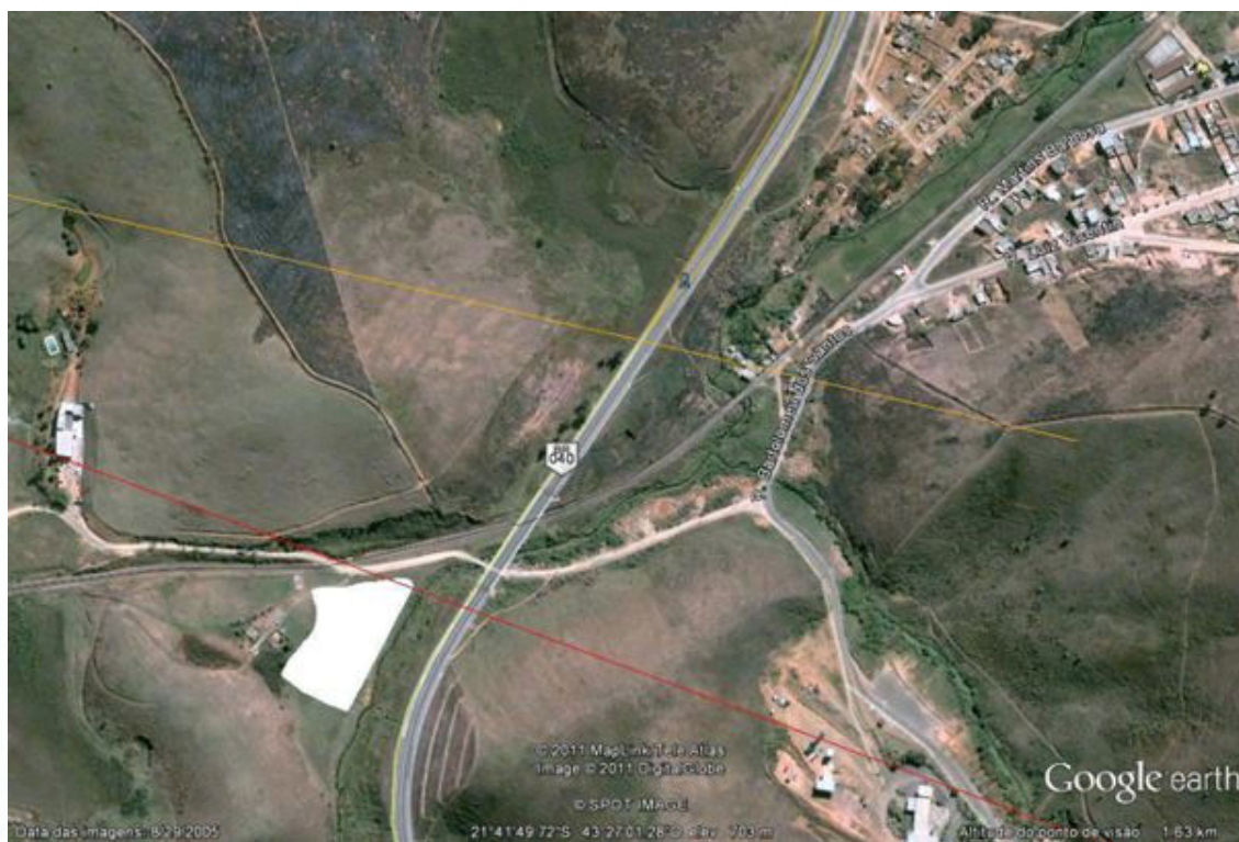
Figura 6 - Área para implantação da bacia de retenção no Córrego Igrejinha na localidade denominada Caracol no Bairro Benfica
