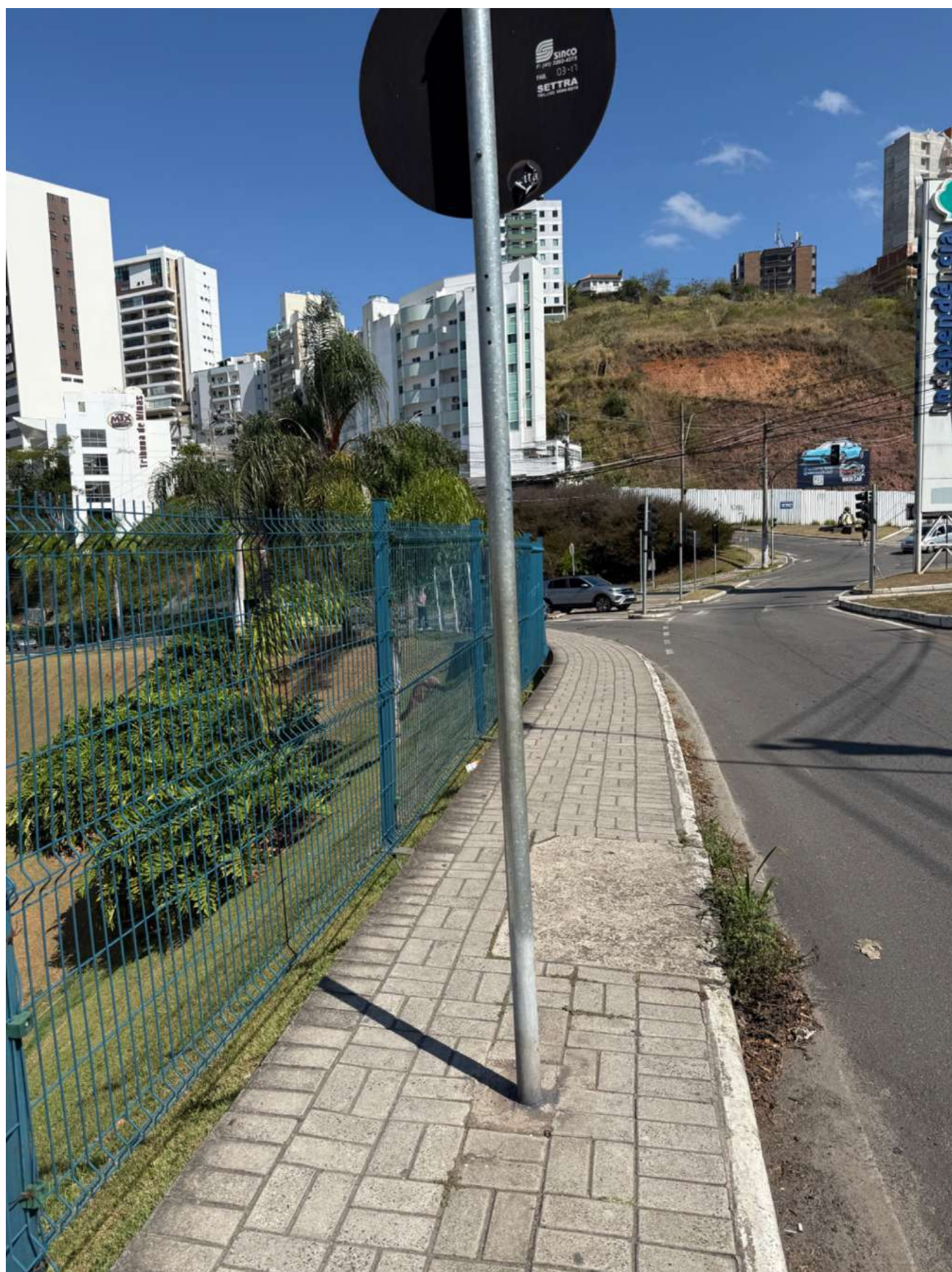
Imagem 3 – Poste centralizado obstruindo faixa livre de circulação
