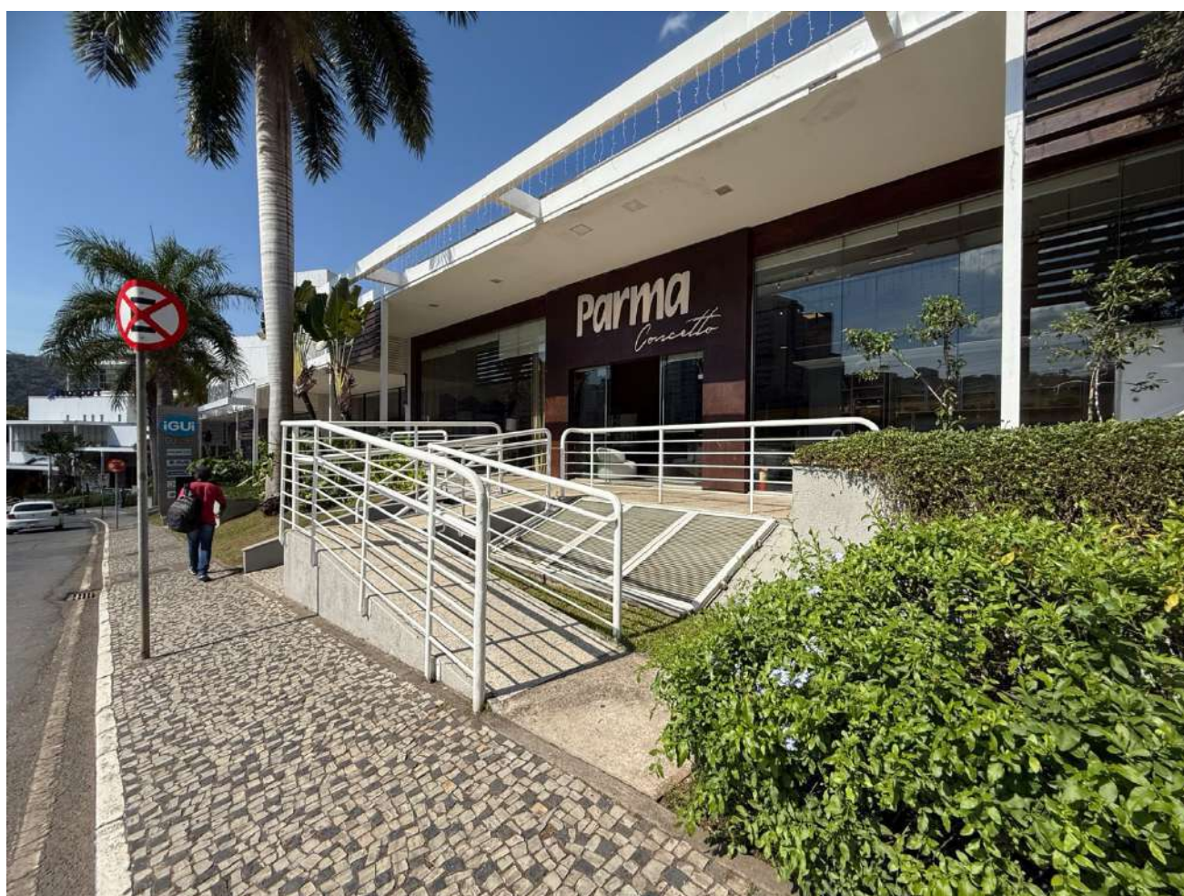
Imagem 1 – Trecho frontal com rampa acessível e piso regular
