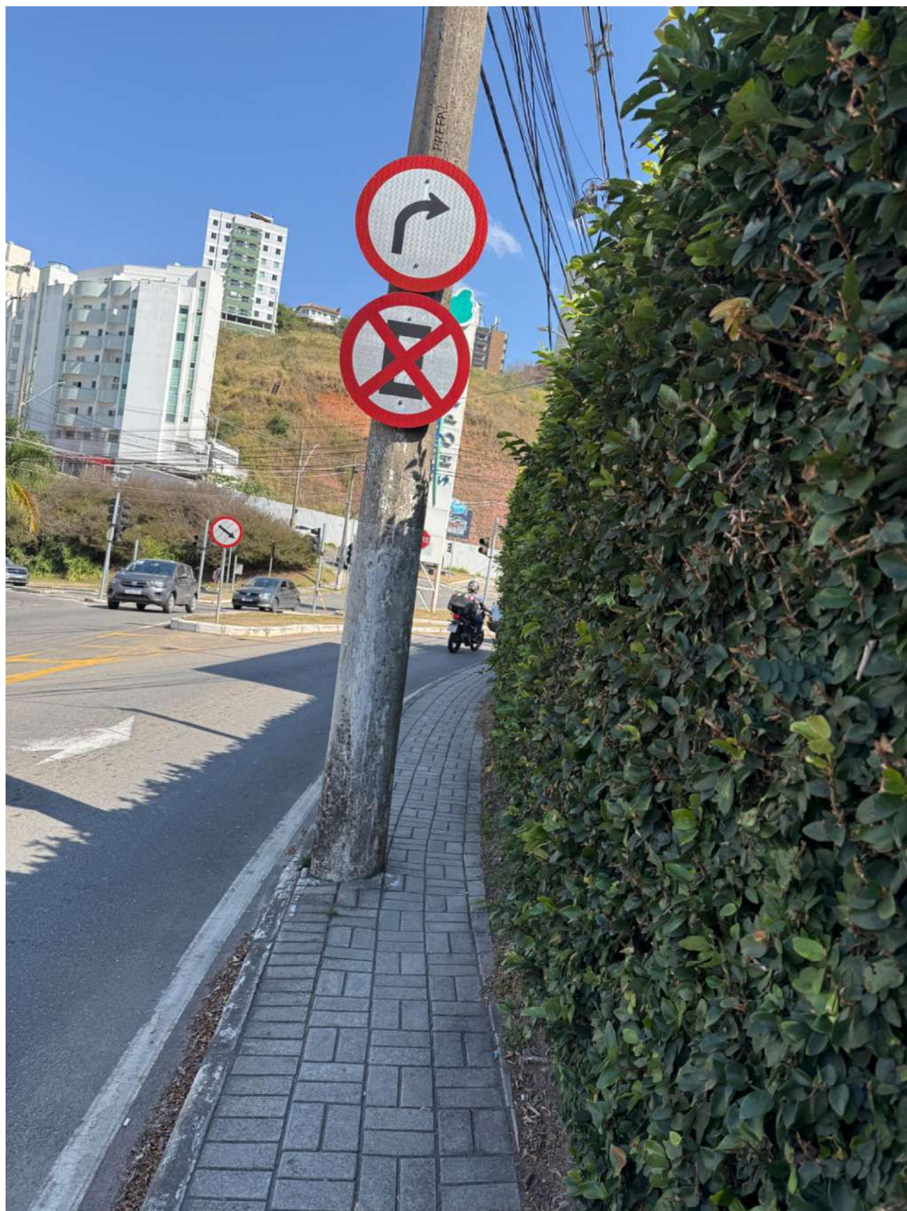
Imagem 4 – Poste centralizado obstruindo faixa livre de circulação
